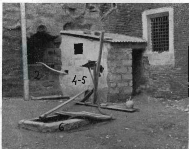
6.—Verdunització de l'aigua corrent d'un poble—que al mateix temps serveix, mitjancant una font especial construïda en una placa, per a omplir camions distribuïdors—aprofitant la instal·lació preexistent, conducta seguida sempre que és possible. Vegi's significació números en fig. següent.
