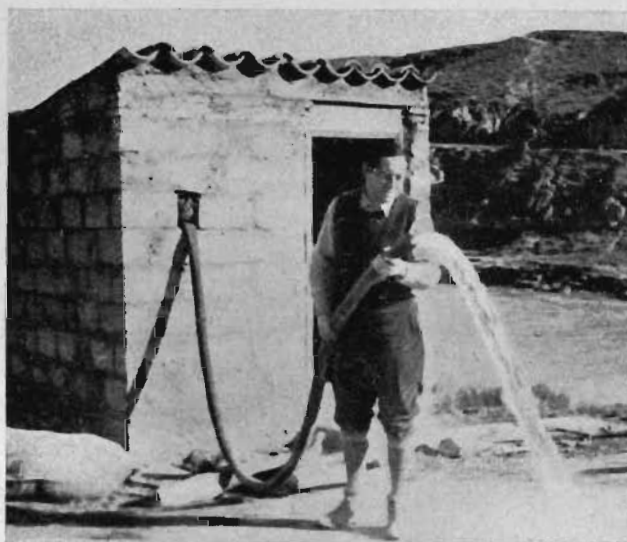
2.—Les bombes centrífugues cloradores per a aigua neta, serveixen un doll d'aigua de dotze tones-hora. Sobre un riu, al marge mateix de la carretera, aquesta caseta de fang—construcció barata genuïnament aragonesa—serveix des de fa molts mesos l'aigua a tot un sector.
