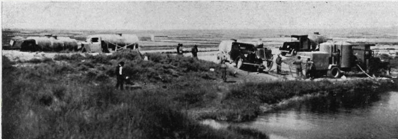
1.—Decantació, filtració i cloratge de l'aigua d'una bassa monegrina pel camió depurador, amb rendiment de sis tones hora. Mentre es carrega un carro per al servei local—abans la bevien bruta i infectada—els camions repartidors s'esperen, a punt de carregar i sortir cap a les posicions militars.
