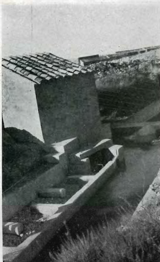
11.—Filtre de grava i carbó per a l'aclariment de l'aigua de la sèquia que proveeix d'aigua S. A la casceta, hi ha un clorador de molinet (fig. 9-10). Amb aquesta instal·lació senzilla resta un servei permanent de filtració i cloratge per a la vila.
