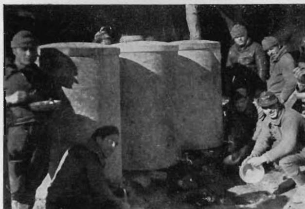
8.—Dipòsits instal·lats en una posició, omplint-los cada dia amb aigua clorada portada pels camions. Els combatents tenen aigua de confiança abundant i han augmentat llurs comoditats amb aquestes instal·lacions. En tot el front hi ha gran nombre de dipòsits com aquests, distribuïts, instal·lats i servits pel S. D. A.
