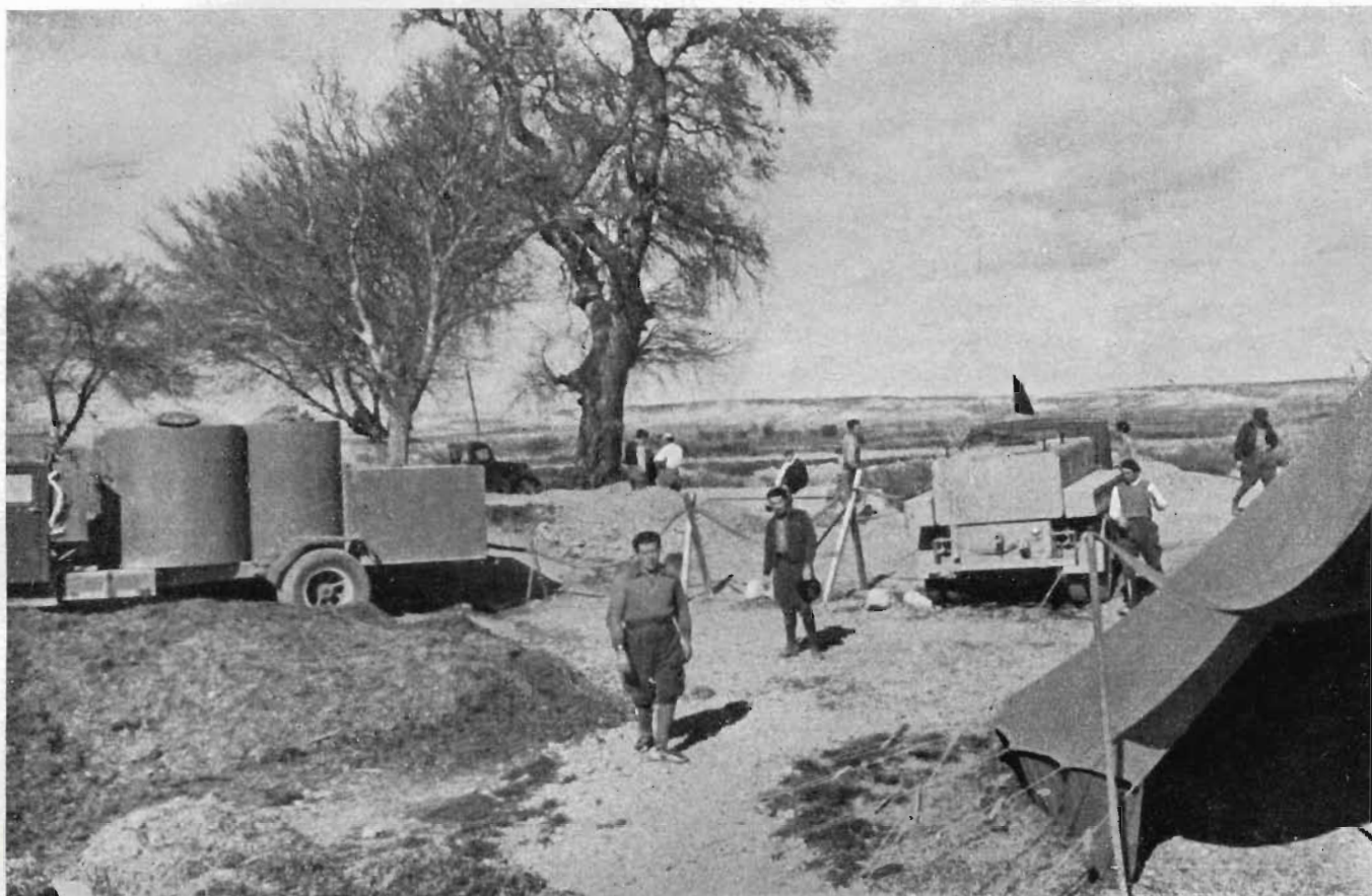
5.—Carregant aigua d'una sèquia pròxima a l'Ebre. A l'esquerra, camió depurador, segons esquema de la figura 3; a la dreta, camió de transport i distribució amb bomba per a omplir dipòsits d'hospitals, casernes, etc., situats a nivell elevat.
